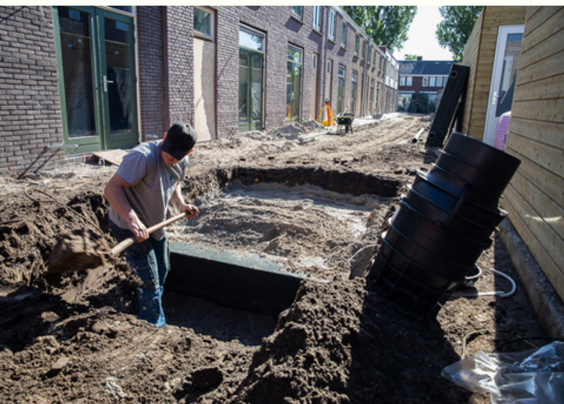
Plaatsing van infiltratiekratten
